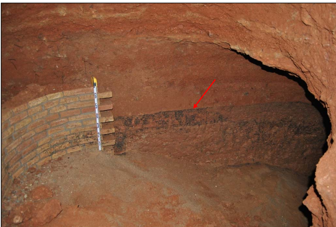
54. Mur de reforç de l'angle Nord del passadís d'accés al refugi. S'aprecia el nivell de residus fruit d'un moment d'inundació de l'estructura en aquest punt.
