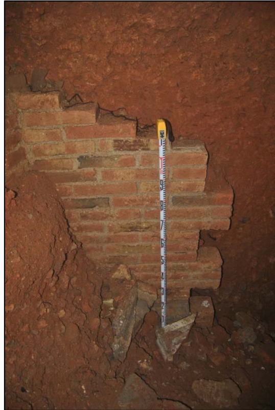
41. Detall del mur de reforç localitzat al final del passadís d'entrada, primer gir-angle.
