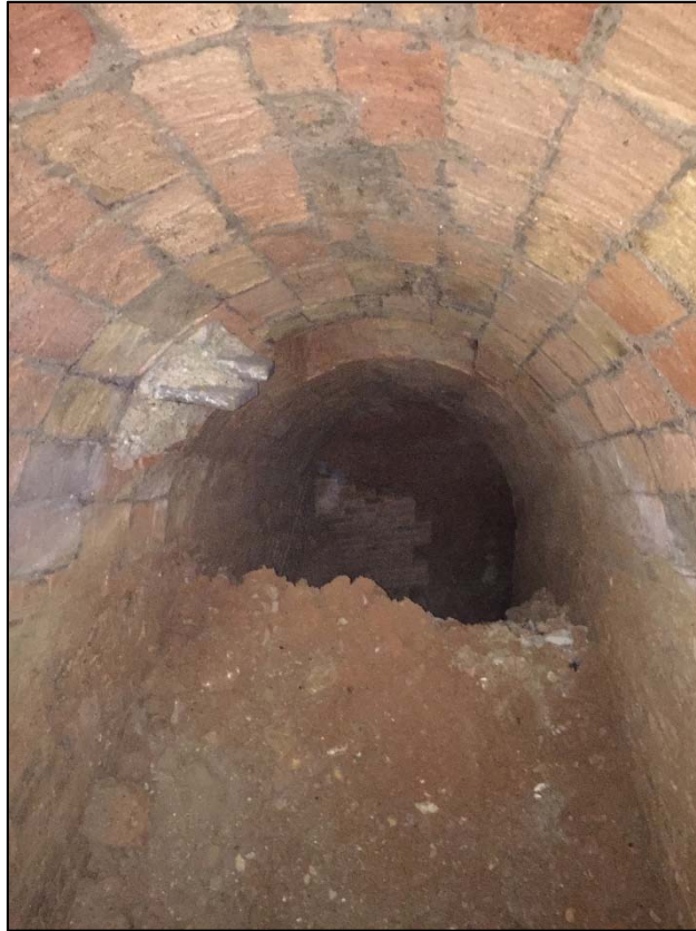
19. Vista de la runa de rebliment, vista del mur de reforç del primer gir-colze.
