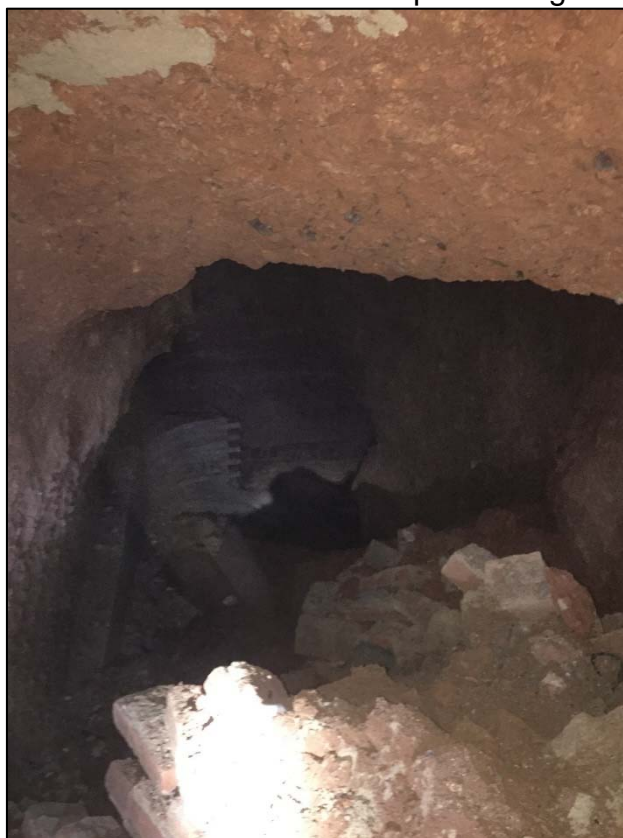
27. Rebliment de runa fins al primer angle-colze.
