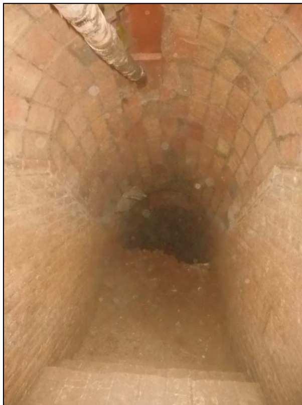
17. Continuació de les tasques d'extracció del rebliment de runa del passadís d'entrada. Estat de l'interior de la construcció.
