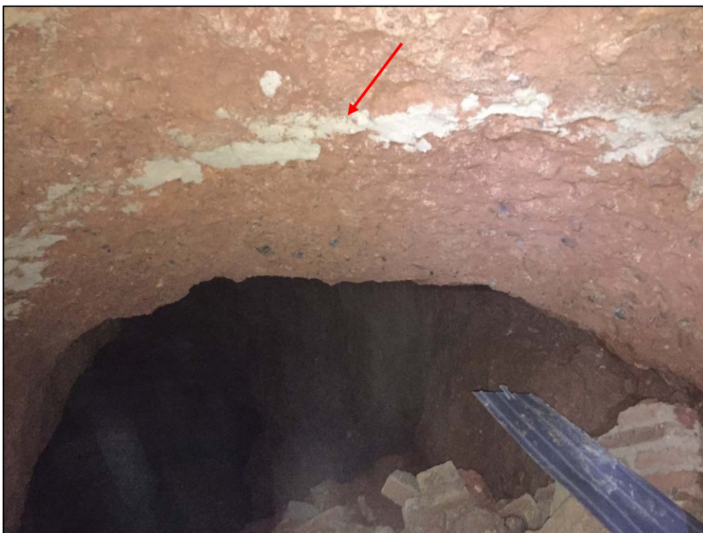
33. Detall del final del tram de volta construït, morter per a mur que tapia la construcció.
