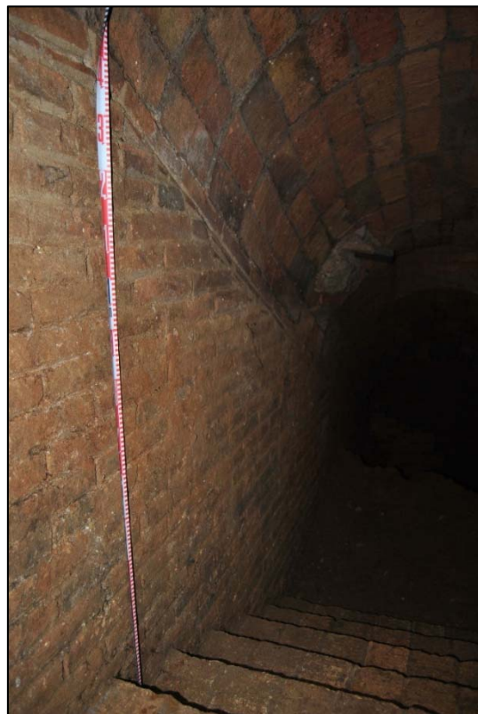
42. Detall del parament sud del passadís d'entrada del refugi.
