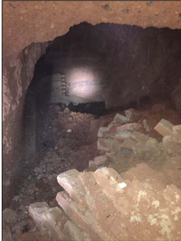
29. Aproximació al mur de reforç del segon gir-angle.
