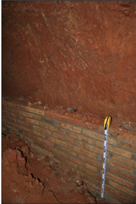
59. Mur de reforç del segon gir, orientació Est. Per sobre s'aprecien les marques dels pics en el procés d'excavació del terreny.
