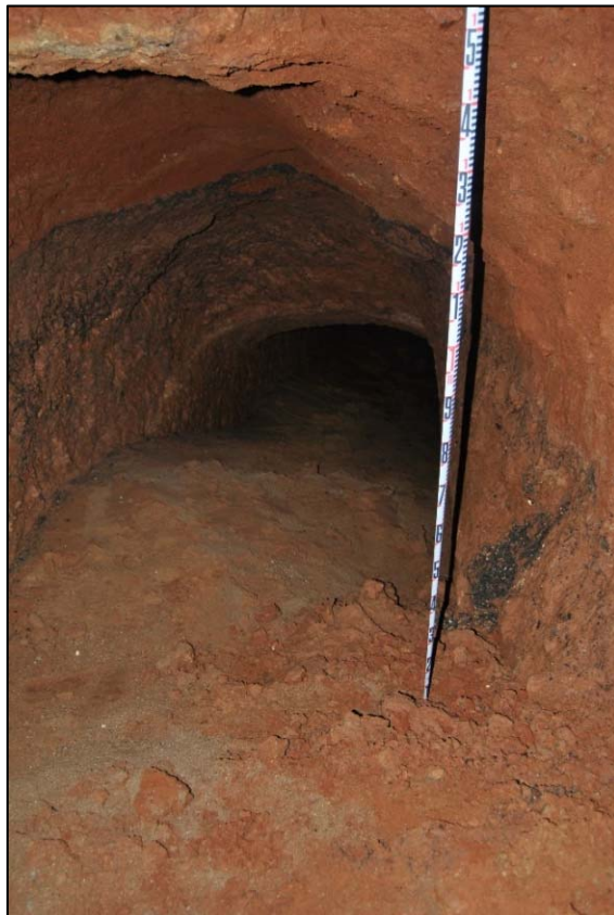
56. Tram final del refugi, excavat directament al terreny.
