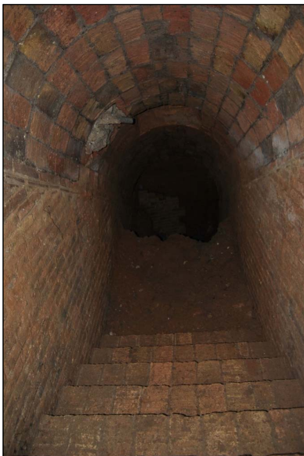
27. Rebliment de runa fins al primer angle-colze.
