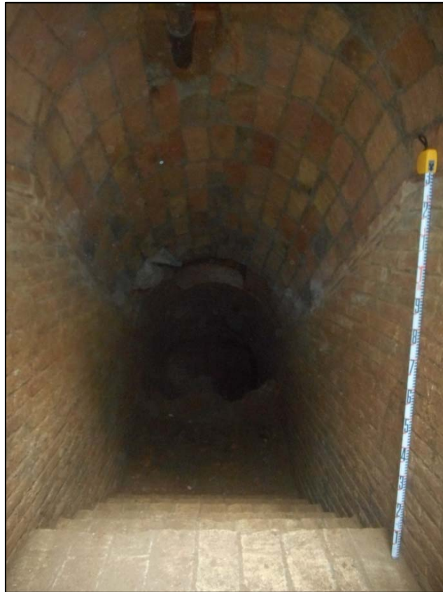
23. Segon tram d'escapes des del primer replà.
