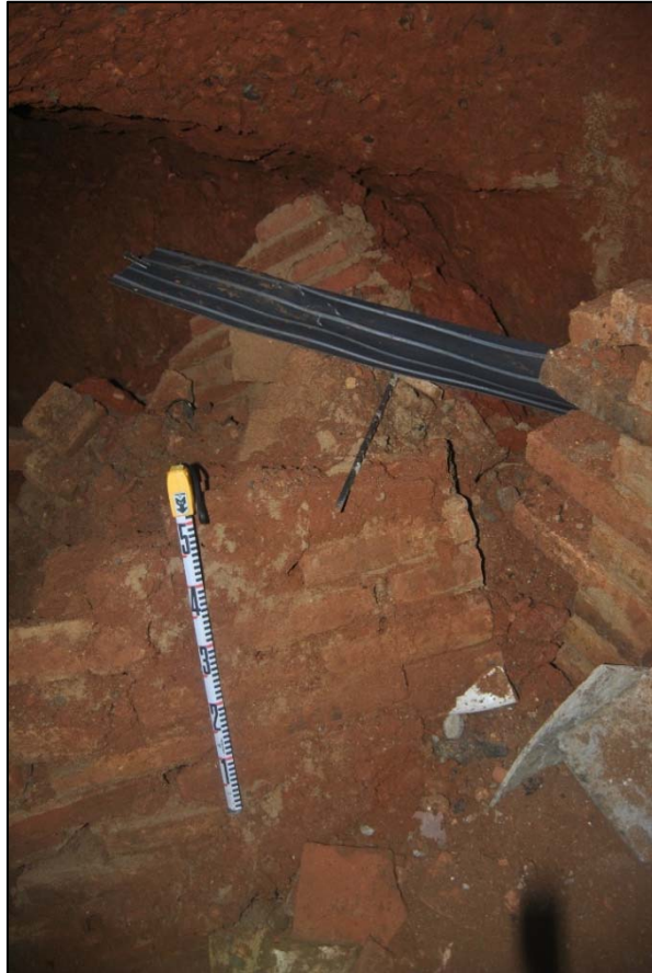
47. Part de la construcció inicial, reforç de l'angle del final del passadís caigut.
