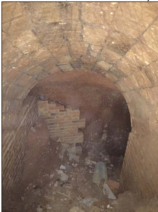
19. Vista de la runa de rebliment, vista del mur de reforç del primer gir-colze.
