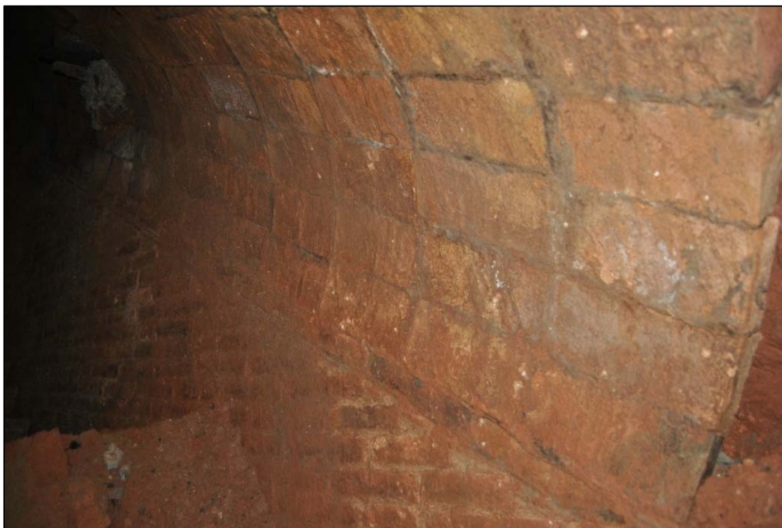
61. Detall de la morfologia de la volta obrada amb rajols.
