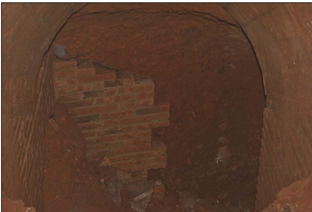
39. Detall del mur de reforç localitzat al final del passadís d'entrada, primer gir-angle.
