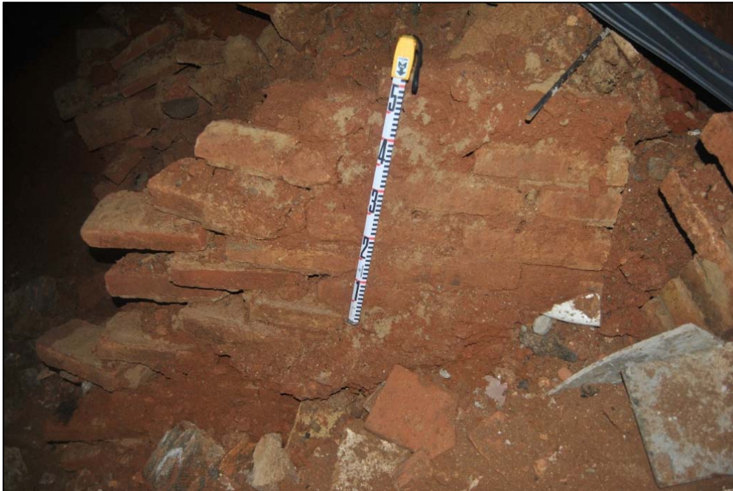
46. Part de la construcció inicial, reforç de l'angle del final del passadís caigut.
