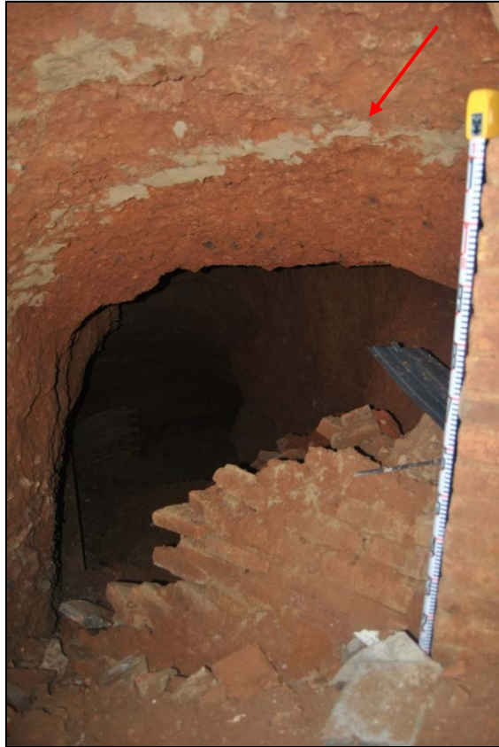
49. Vista de les restes de morter del mur que tapiava el final del passadís d'accés al refugi.
