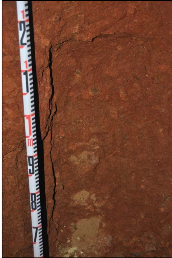
43. Detall d'encaix excavat al terreny, possible encaix per al mur de tapia.
