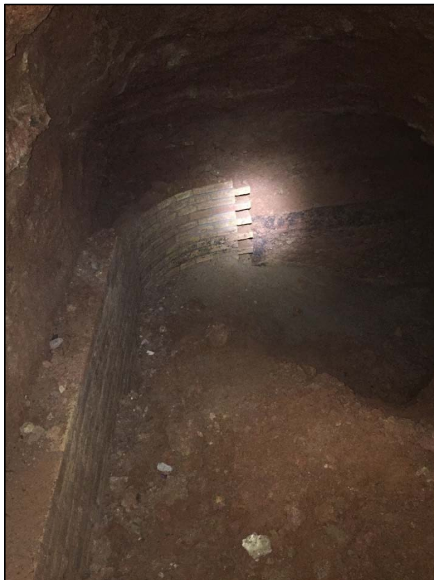
32. Detall del segon mur de reforç a l'angle Nord del tram de galeria.
