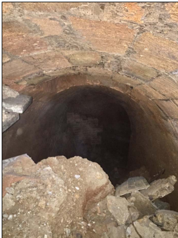
7. Vista inicial (al fons) del primer angle-colze del passadís d'entrada.
