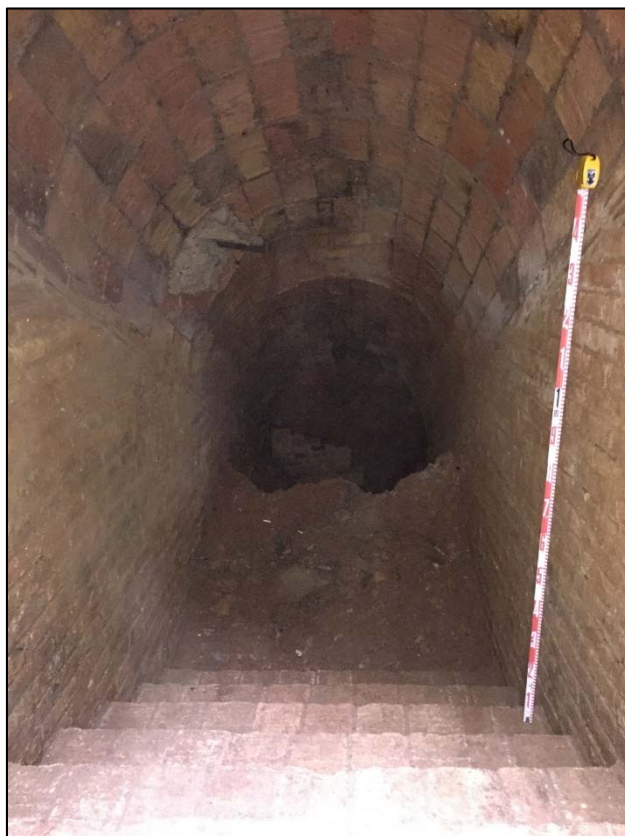
26. Rebliment de runa fins al primer angle-colze.
