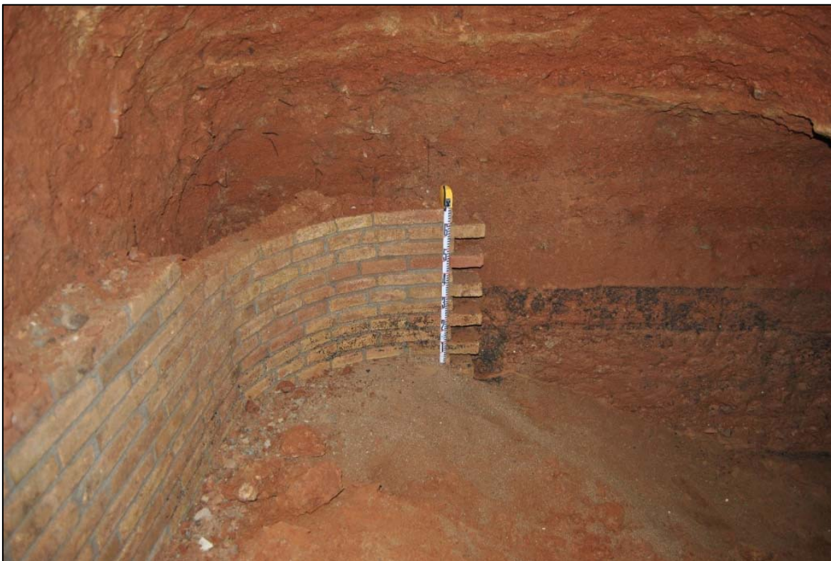
53. Mur de reforç de l'angle Nord del passadís d'accés al refugi.
