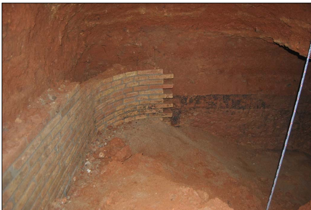
52. Mur de reforç de l'angle Nord del passadís d'accés al refugi.
