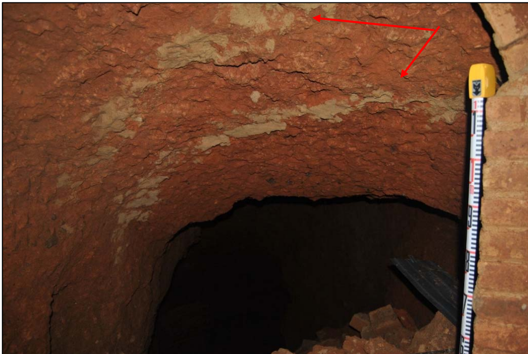
48. Vista de les restes de morter del mur que tapiava el final del passadís d'accés al refugi.
